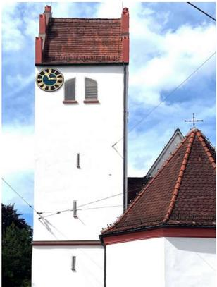
In den vergangenen 2 Jahren wurde der Turm unserer St. Leonhard Kapelle außen saniert. Lange war er mit einem Gerüst versehen. Es erfolgte die Erneuerung des Außenputzes und ein neuer Anstrich. Während der Bauarbeiten zeigte sich, dass bei den Zinnen Gefahr im Verzug war und auch diese überarbeitet und erneuert werden mussten. Ebenso wurden die Zifferblätter der Turmuhr, die Zeigerantriebe und die Schlagwerksverteiler erneuert.
